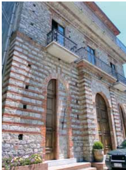
San Costantino di Rivello, edificio costruito nel primo '900 da Carmine Regina, emigrato a Faro, sul Rio delle Amazzoni
